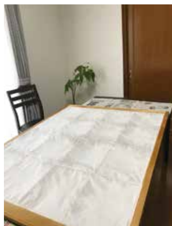
障子貼り作業の様子
